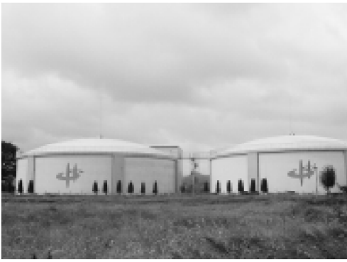
上鯖江の上水道管理センター 水を貯え滅菌処理し全自動で各家庭に給水しています
